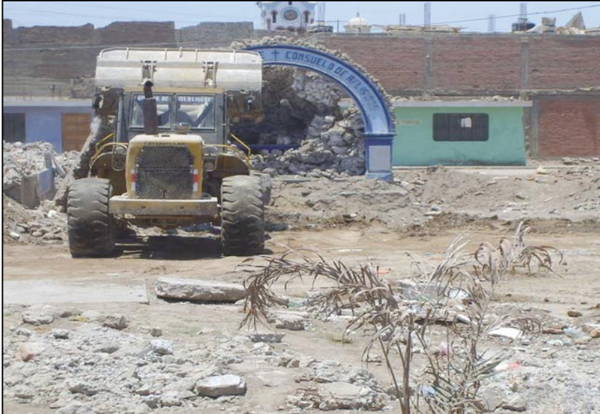
Foto 11 Demolición del Hospital San Juan de Dios Pisco
