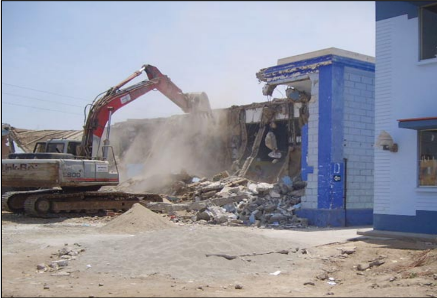
Foto 9 y 10 Demolición del Hospital San Juan de Dios
