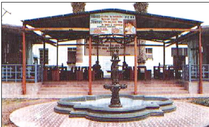
Foto 2 Consultorios externos de pediatría antes del terremoto
