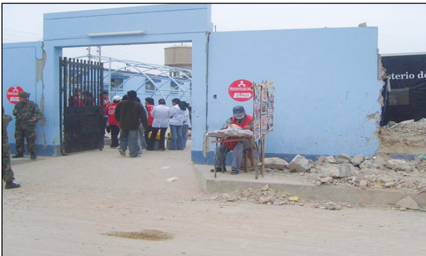
Foto 4 Puerta de emergencia: se aprecia el pabellón nuevo en el interior
